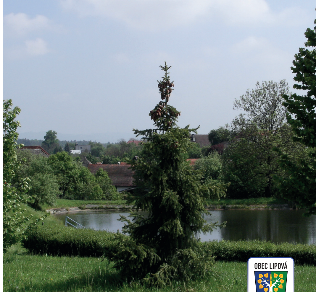
Vodní nádrž před rekonstrukcí
